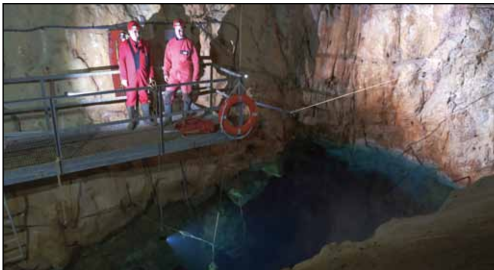
Barrage Souterrain de Port Miou
